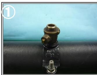
① 穿孔する管にサドル付分水栓（分岐サドル）を取付け、バルブを開けておきます。
