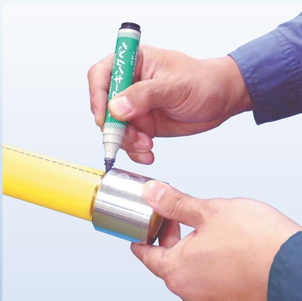
スクレップエリアの長さを測って、ペンで管を一周ぐりと線を描くのは熟練した方でも難しいものです。このスクレップエリアマーカを使用すれば、管径に対応したスクレップ長に合わせてあるので、奥まで差込んでスクレップエリアマーカにそってペンで書けばきれいで簡単に線が引けます。
